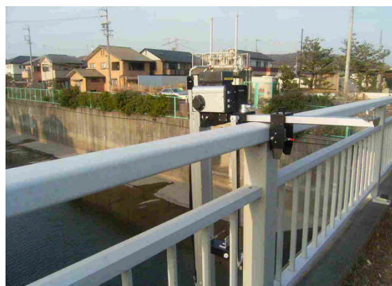
写真-3 高欄の笠木にポールユニットを設置
