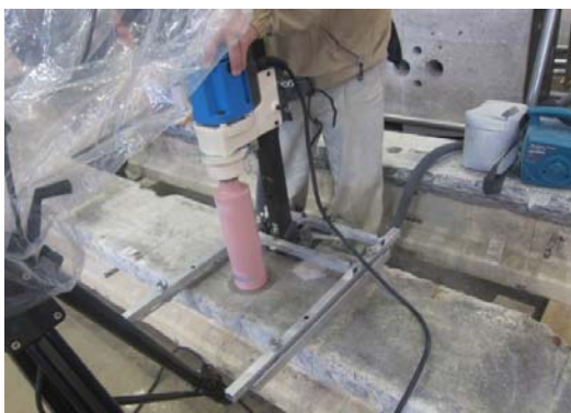
写真-4 削孔状況
