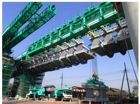
写真-6 セグメント架設状況
