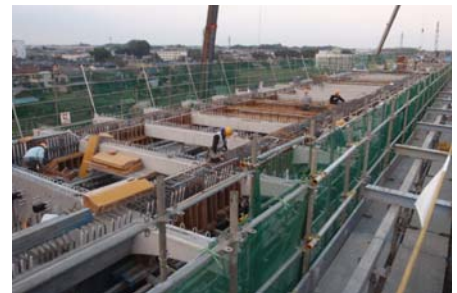
写真-5 プレキャスト部材の使用
