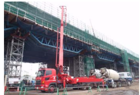
写真-4 固定支保工部施工状況
