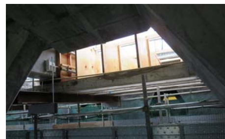
写真-2 間詰め部型枠
