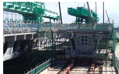
写真-1 子セグ柱頭部施工状況
