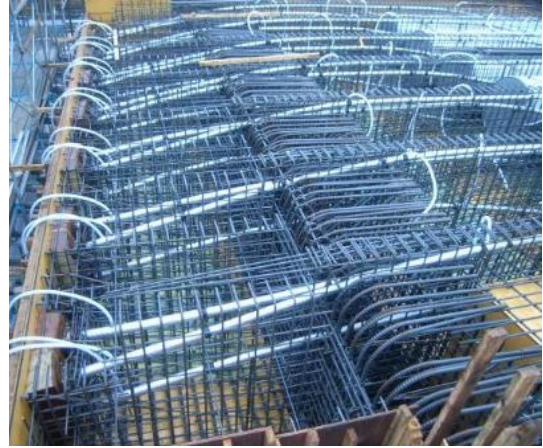
写真-2 組立て状況
