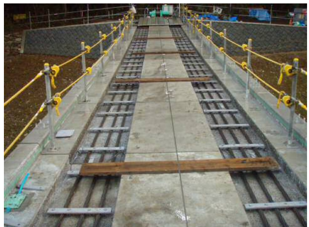
写真-2 プレキャスト床版固定状況
