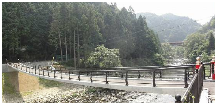
写真-5 完成写真 (全景)
