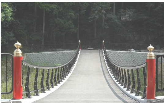
写真-4 完成写真 (橋面)
