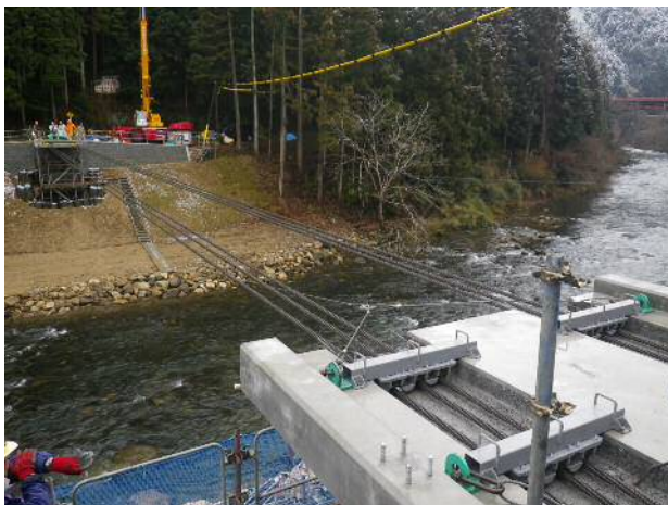
写真-1 プレキャスト床版架設状況
