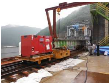
写真-5 鋼桁撤去
