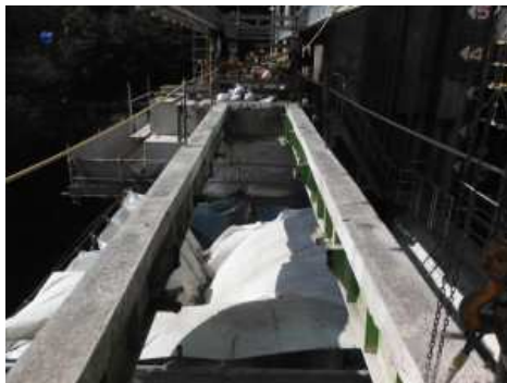
写真-3 鋼桁撤去前
