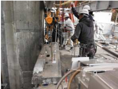
写真-1 張出床版撤去
