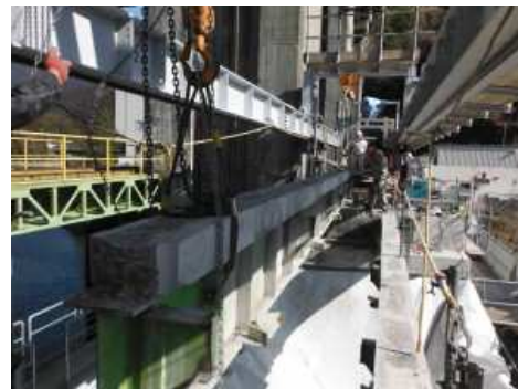
写真-4 鋼桁撤去
