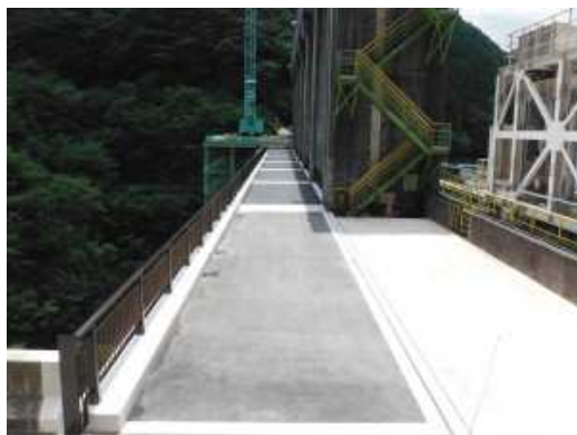
写真－10 完成写真
