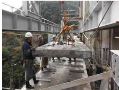
写真-2 中間床版撤去
