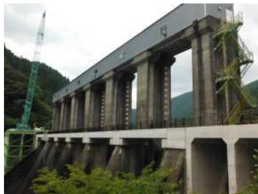
写真－11 完成写真
