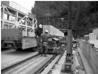
写真－7 門構によるPC桁荷卸 写真－8 自走台車による桁の移動 写真－9 架設桁による架設
