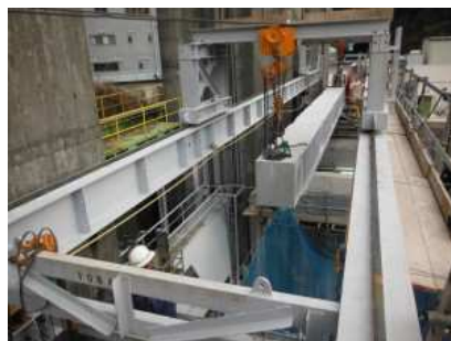
写真－7 門構によるPC桁荷卸 写真－8 自走台車による桁の移動 写真－9 架設桁による架設
