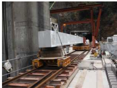
写真－7 門構によるPC桁荷卸 写真－8 自走台車による桁の移動 写真－9 架設桁による架設
