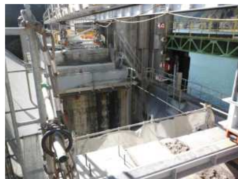
写真-6 旧橋撤去完了
