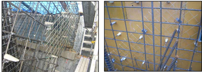
写真-1 FRP 格子筋の配置状況 (橋脚基礎部側面)
