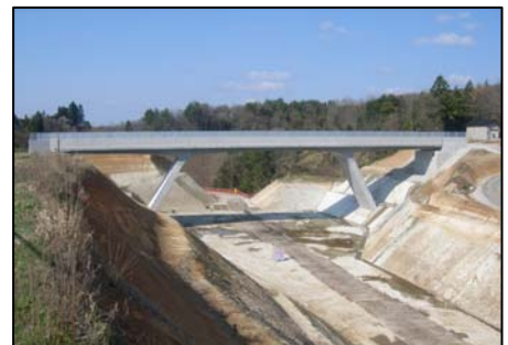
写真-7 完成写真
