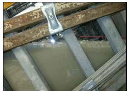
写真-3 壁式橋脚打設状況 (打込み高さ確認)
