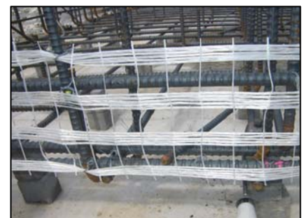
写真-6 ガラス繊維補強材の設置
