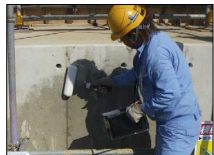
写真-5 高性能収縮低減剤塗布状況
