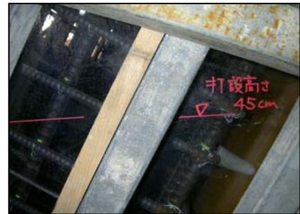
写真-2 透明型枠使用 (透明アクリル樹脂板)
