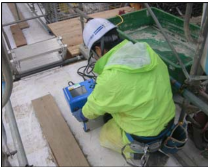
写真-4 コンクリート充填・締固め管理状況
