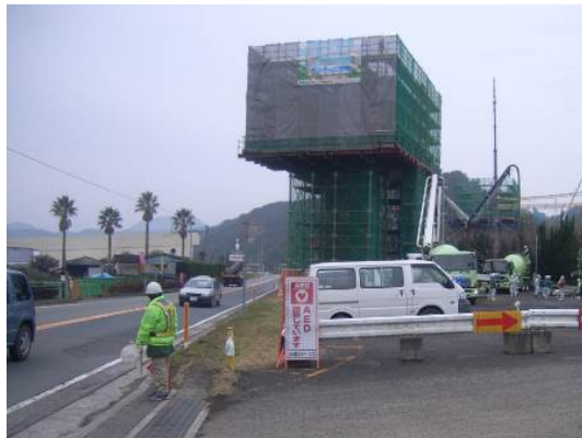
写真-3 P4 柱頭部支保工設置完了
