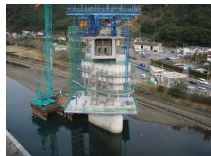
写真-7 P5 支保工組立て全景
