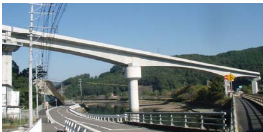
写真-1 完成 (終点側より)
