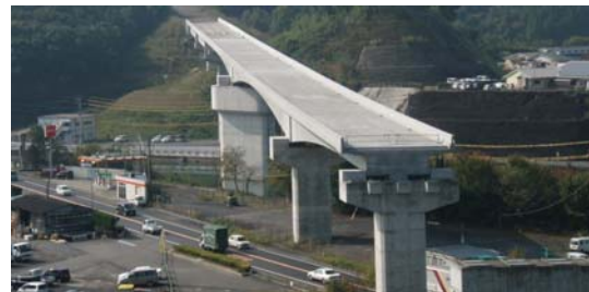
写真-2 完成 (起点側より)
