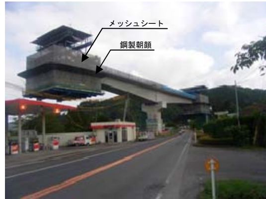
写真-4 P4 片持架設全景
