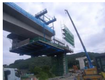
写真-6 P3 側径間支保工組立て全景
