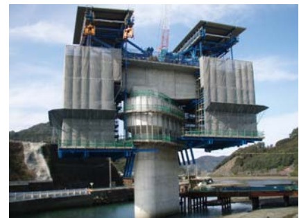
写真-8 P5 支保工組立て完了
