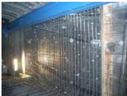
写真-8 主ケーブル施工全景
