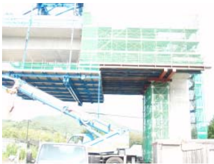
写真-5 P3 側径間支保工組立て完了
