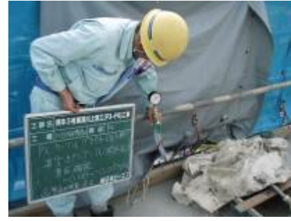
写真-11 真空ポンプによる負圧確認
