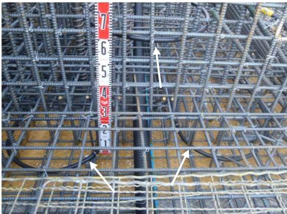
写真-3 クーリングパイプ配置状況
