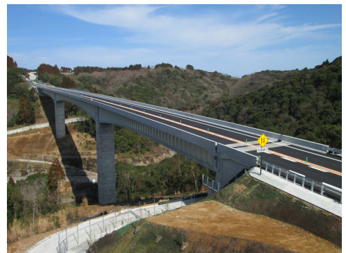
写真-4 完成写真
