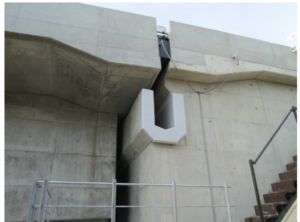
写真-2、3 セットバックジョイント構造
