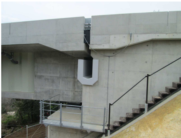
写真-2、3 セットバックジョイント構造
