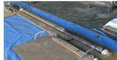
写真-3 アラミドFRP緊張材製作状況
