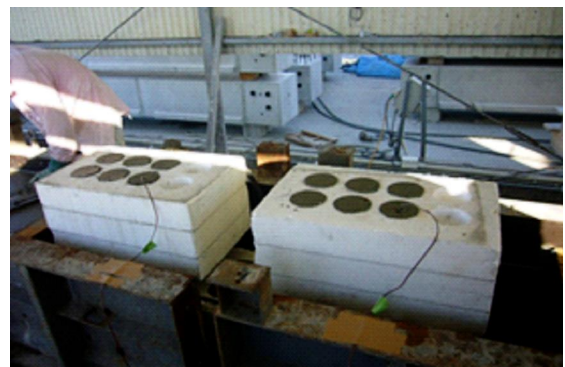
写真-1 簡易断熱養生の状況
