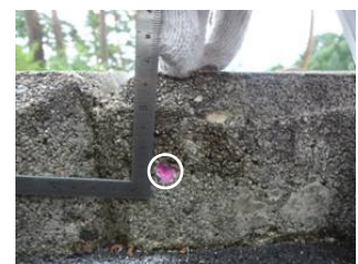
写真-4 中性化深さ測定
