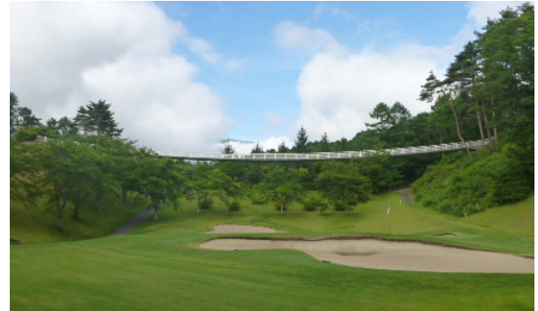
写真-1 あづみの吊床版橋
