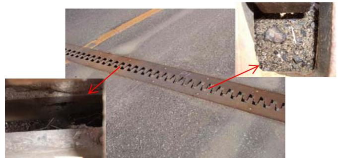
写真-3 PC橋の遊間の土砂堆積
