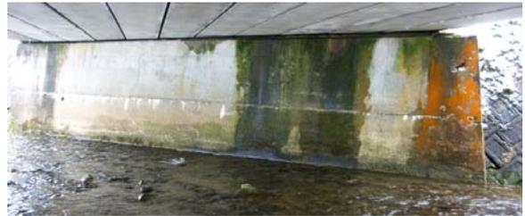
写真-1 橋台前面の漏水
