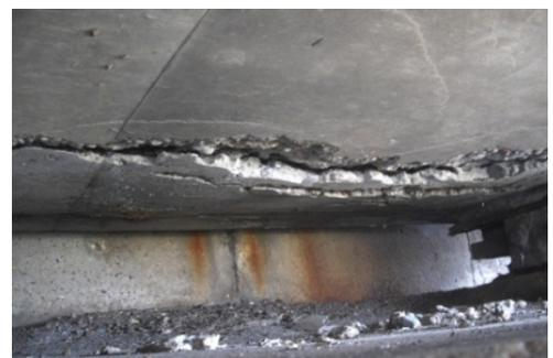
写真-7 PC箱桁端部下面の塩害事例
