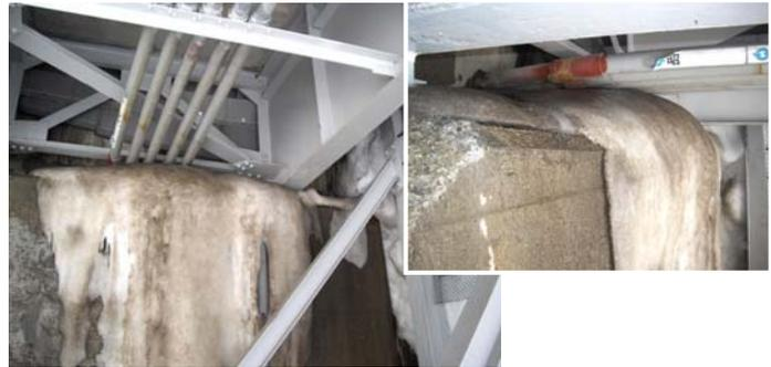
写真-6 伸縮装置からの漏水および橋台背面からの流水の凍結 (鋼橋の例)
