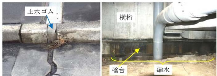
写真-4 歩車道境界の止水ゴムの損傷(左)とその直下の桁端部の漏水(右)
