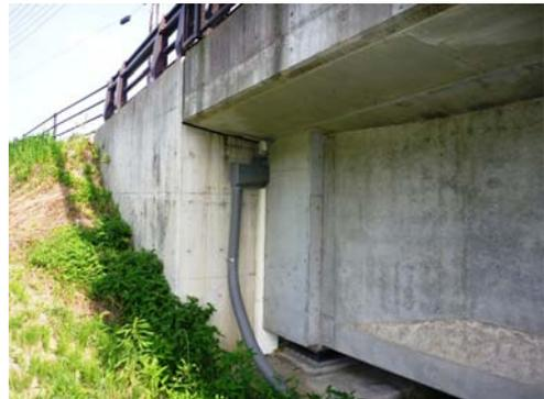
写真-9 2径間連続PC橋における試験的な設置，ポリエチレン製排水装置を100mmの遊間に挿入<sup>10)</sup>
