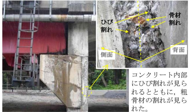
写真-2 橋脚側面の漏水(鋼橋の例)
