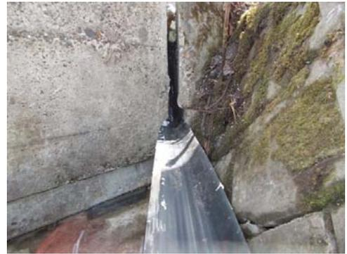
写真-8 単径間PC床版橋における試験的な設置，ゴム製排水装置を70mmの遊間に挿入<sup>10)</sup>
