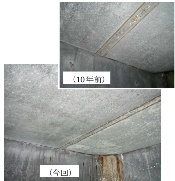
写真-3 CFRP 床版下面の状況
