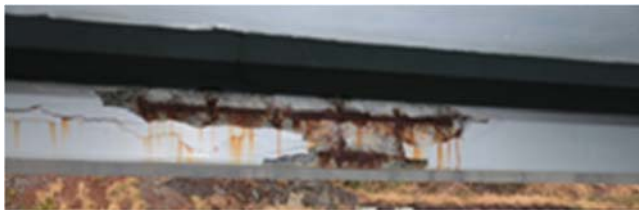
写真-1 主桁変状の状況
