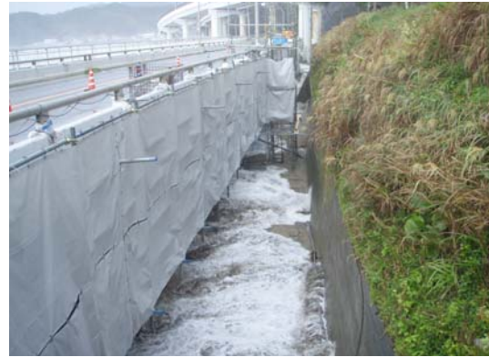
写真-2 現場環境(山側：荒天時)
