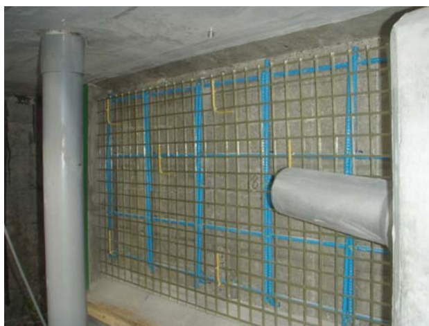
写真-5 ガラス繊維グリッド配置状況
