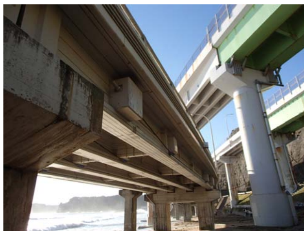
写真-6 外ケーブル補強完了写真
