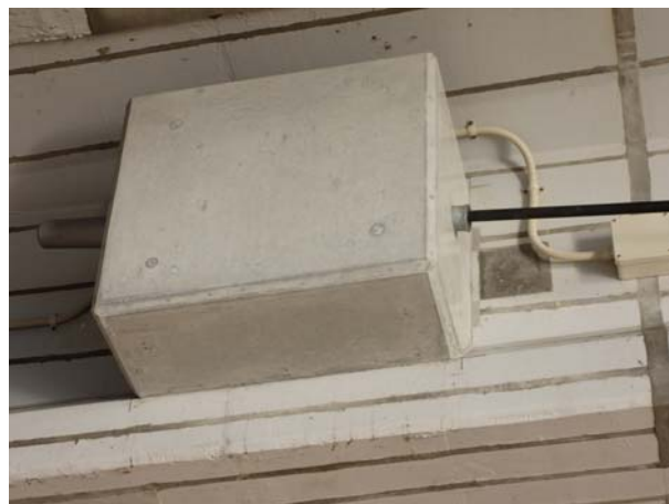
写真-3 定着部施工完了
