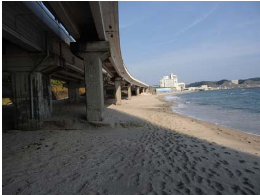
写真-1 現場環境(海側)
