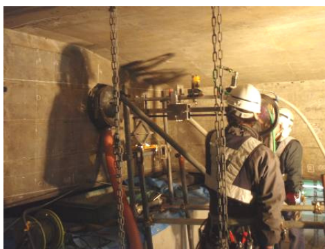
写真 - 3 WJ 削孔状況
