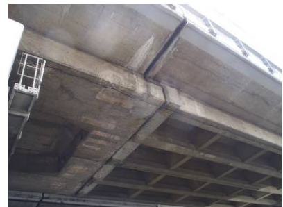
写真-2 ゲルバーヒンジ部
