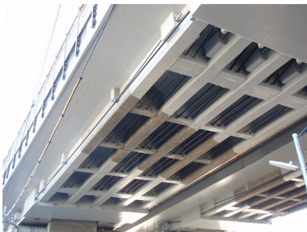
写真 - 9 完成写真（PCT 桁）
