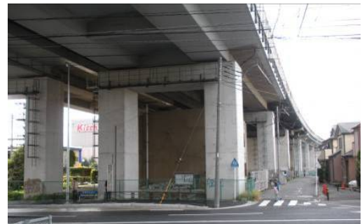
写真-1 施工前状況
