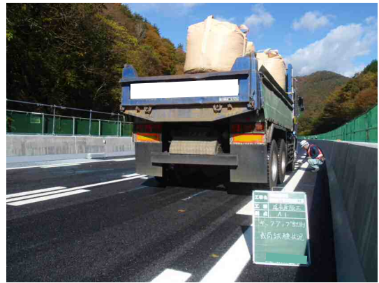
写真-4 試験車両荷重状況
