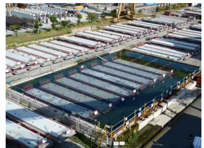
写真-2 水中養生状況
