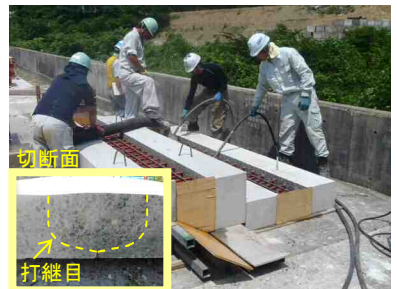
写真-3 打設試験状況
