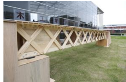
写真 - 6 せん断補強パネル
