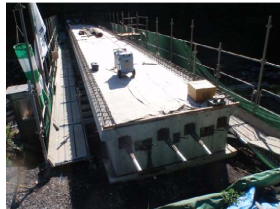
写真-5 PC鋼材緊張前全景
