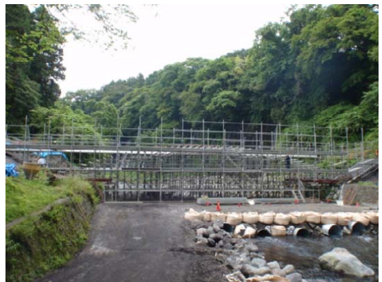
写真-2 支保工設置状況
