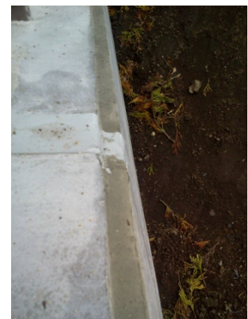
写真-6 水切り用面取り部
