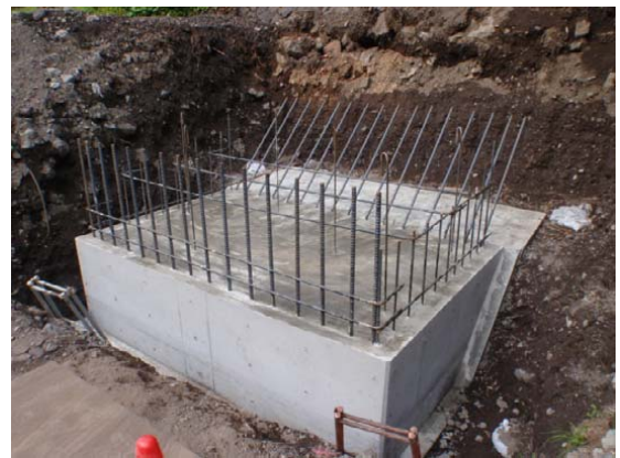
写真-1 下部工基礎施工状況
