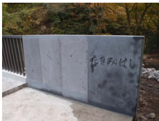
写真-9 地覆コンクリート打設状況
