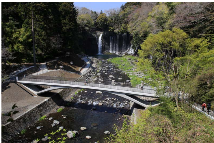
写真-10 橋梁全景
