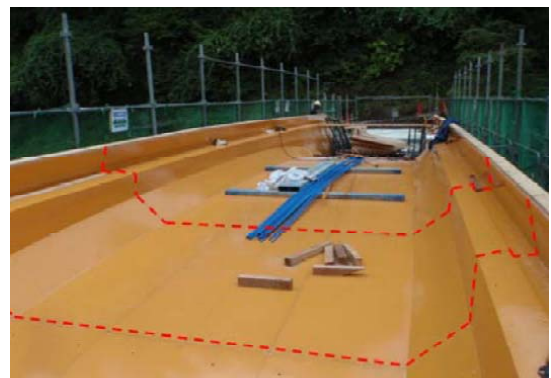
写真-3 型枠設置状況(破線は型枠目地位置)
