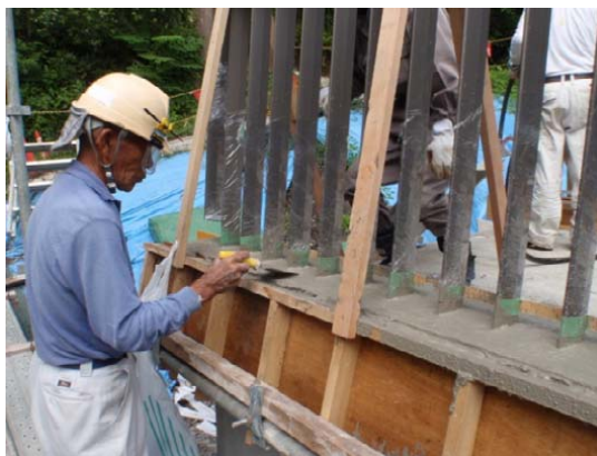
写真-7 地覆コンクリート打設状況
