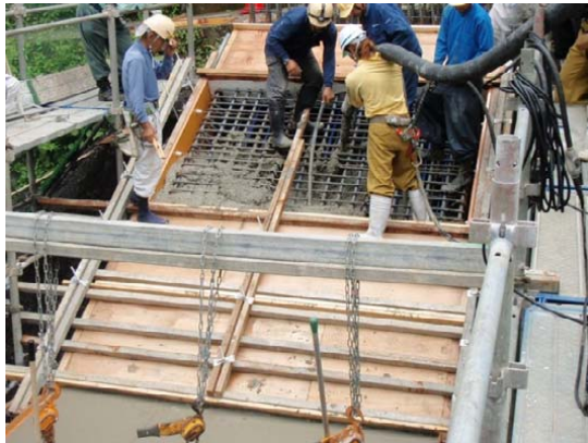
写真-4 伏せ型枠設置・コンクリート打設状況
