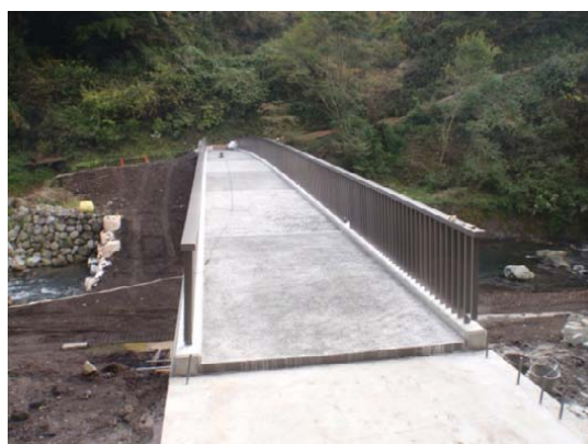
写真-8 地覆コンクリート打設状況
