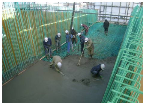
写真-2 打設状況(第2リフト)
