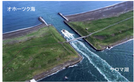
写真-1 橋梁施工前の第2湖口(航路幅50m)
