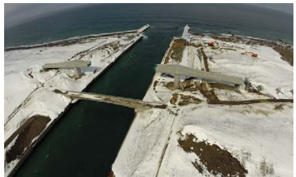
写真-3 平成26年4月現在の施工状況
