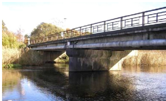
写真-1 対象橋梁の全景（上流側より撮影）
