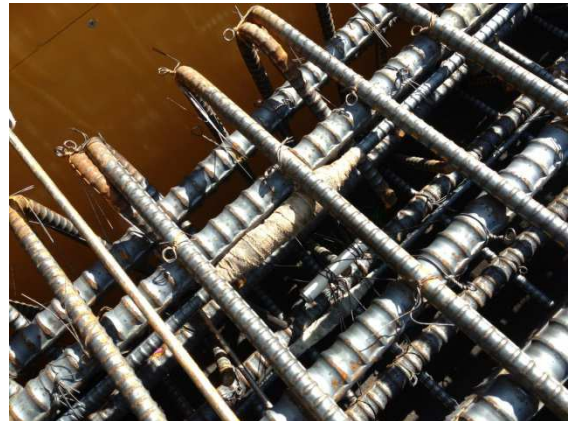
写真-2 ひずみ計設置の様子
