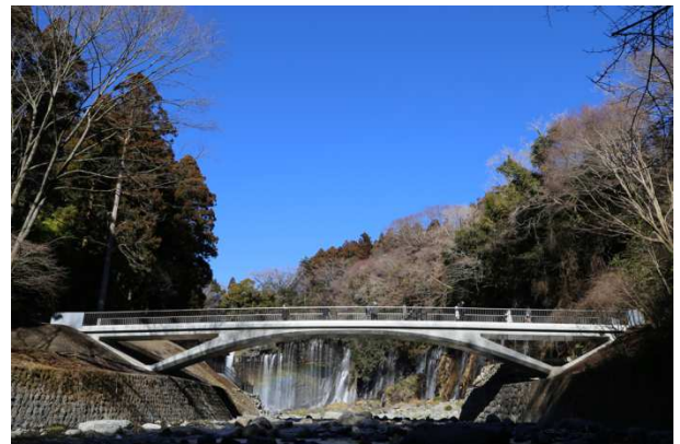
写真-1 滝見橋の全景
