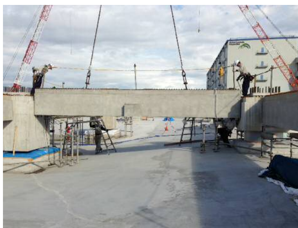
写真-2 大梁の架設
