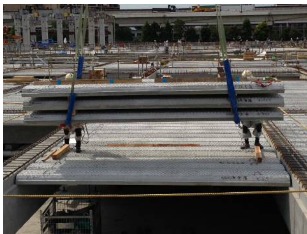
写真-3 PC合成床板の架設
