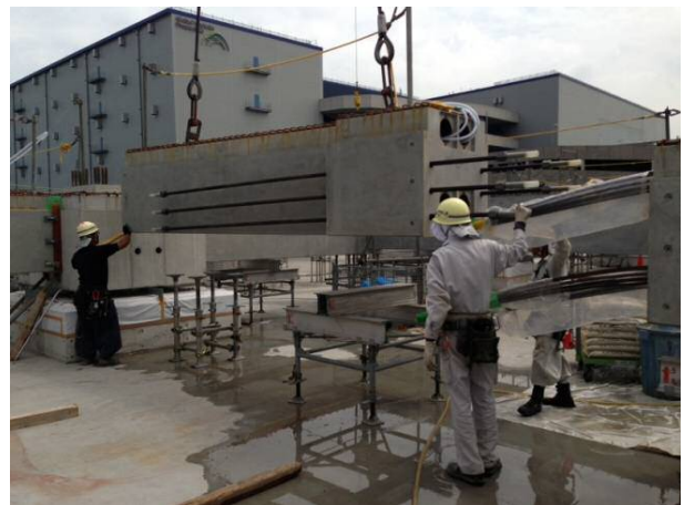
写真-4 ムーブスパンの架設(1)
