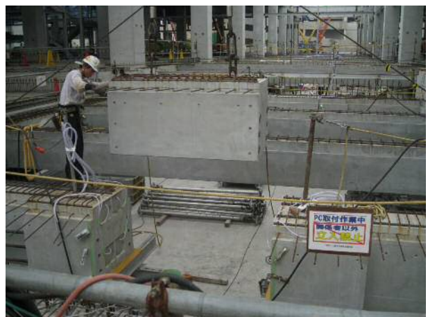
写真-5 ムーブスパンの架設(2)
