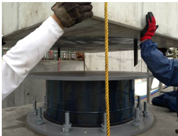
写真-1 免震ブロックの架設
