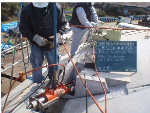
写真－9 版締め PC 鋼より線緊張
