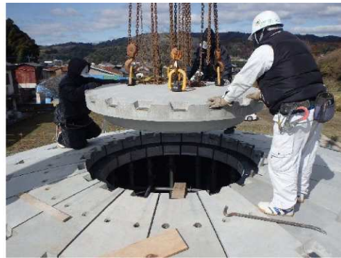
写真－6 PCa 蓋版部材架設
