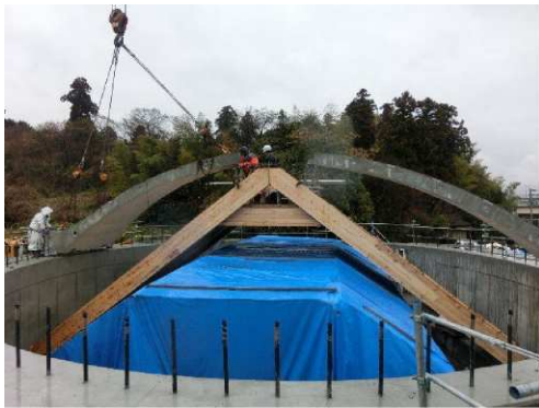
写真－5 PCa ドーム部材架設
