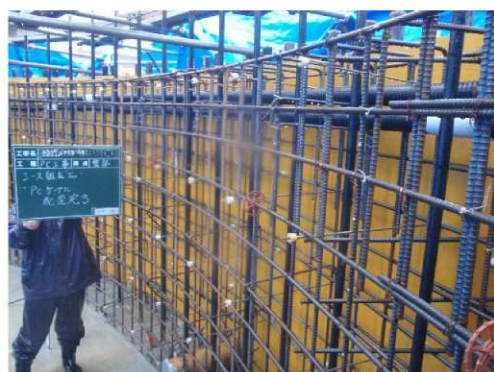
写真-4 横締めケーブル組立
