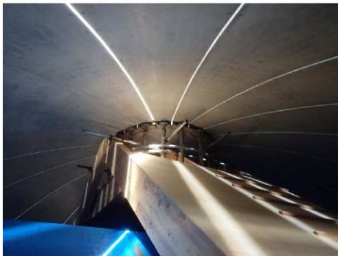
写真－7 施設内部
