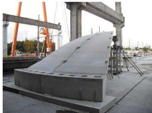
写真-2 PCaドーム部材の仮組み
