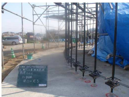
写真-3 縦締めPC鋼棒建込み
