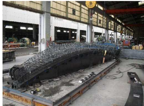
写真-1 PCaドーム部材の製作状況
