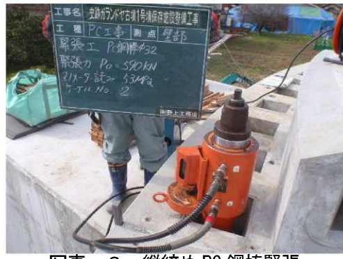
写真－8 縦締め PC 鋼棒緊張
