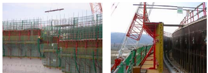
写真-3 クライミング状況 写真-4 型枠を後方シフト
