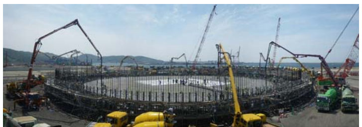
写真-2 基礎版コンクリート打設状況
