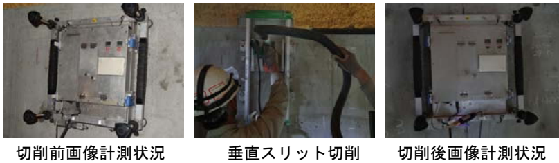
写真—2 スリット応力解放法 施工状況
