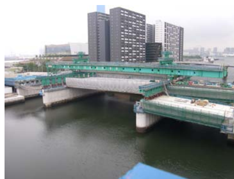
写真-6 桁架設
