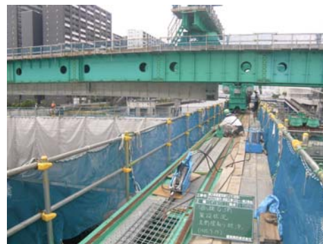
写真-5 桁横移動
