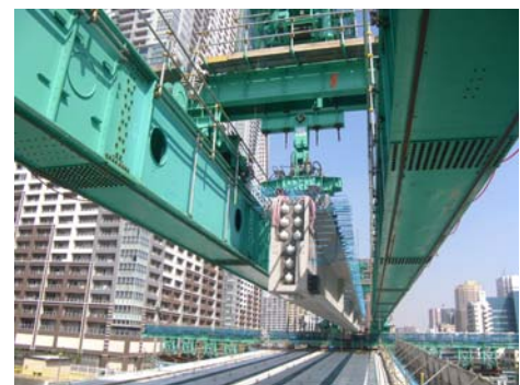
写真-4 桁引き出し
