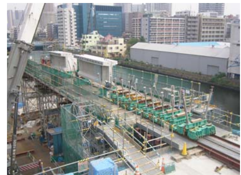
写真-3 セグメント桁組立て
