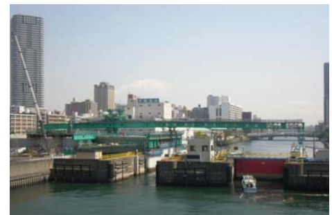
写真-2 架設桁組立て完了
