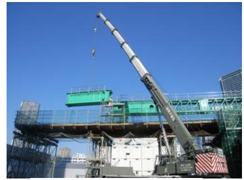
写真-1 架設桁組立て
