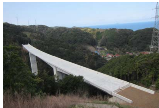
写真-6 完成写真
