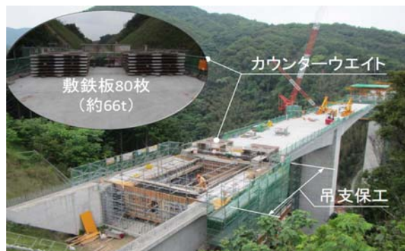
写真-1 ウエイト設置状況
