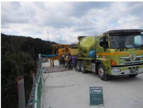
写真-4 コンクリート打設状況
