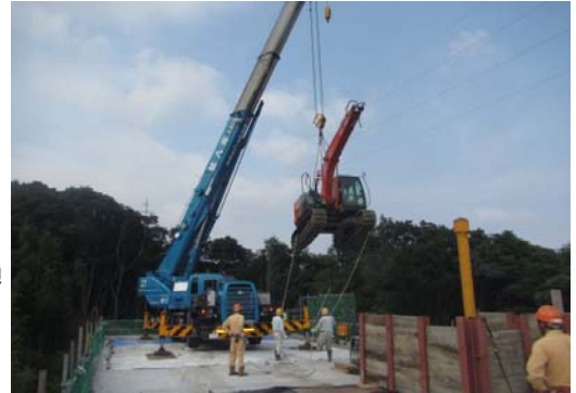
写真-3 バックホウ揚重状況
