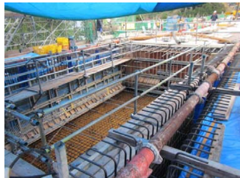
写真-5 圧送用配管組立状況
