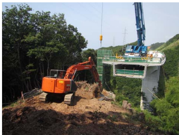
写真-2 張出し先端での施工状況
