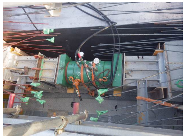
写真-5 水平加力装置
