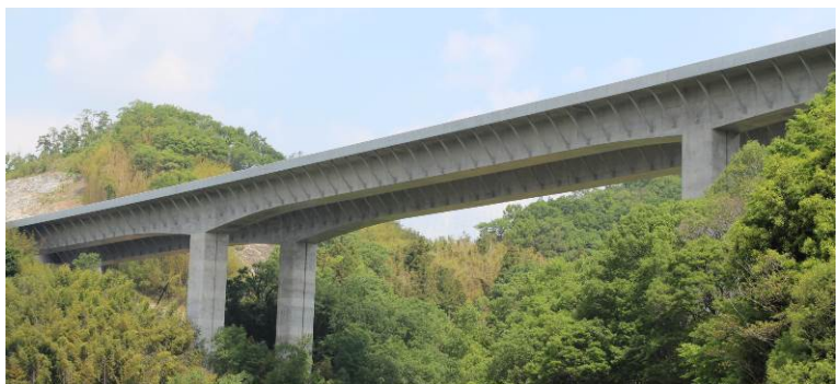
写真-6 完成写真 (平成 26 年 5 月撮影)
