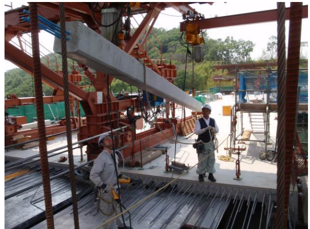
写真-2 ストラット設置状況
