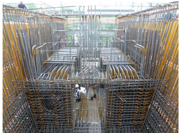
写真-1 柱頭部鉄筋組立状況
