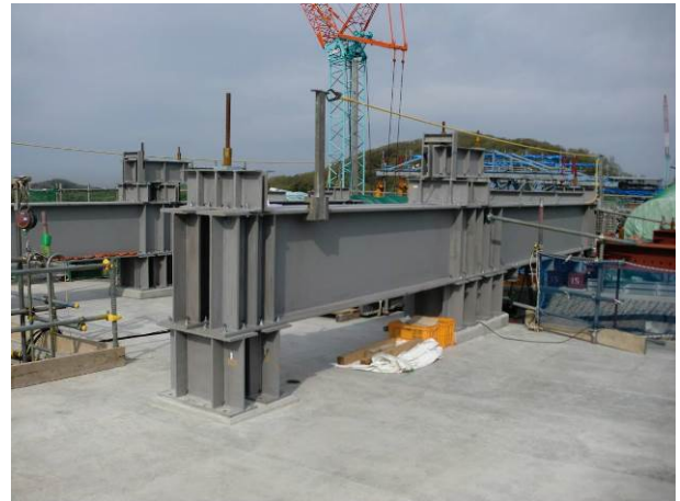
写真-4 鉛直調整装置
