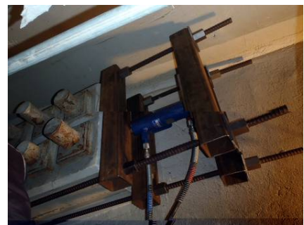
写真-4 実施工における撤去状況
