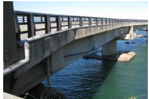
写真-1 外ケーブル補強工法の事例
