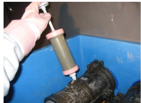
図-3 モルタル注入状況
