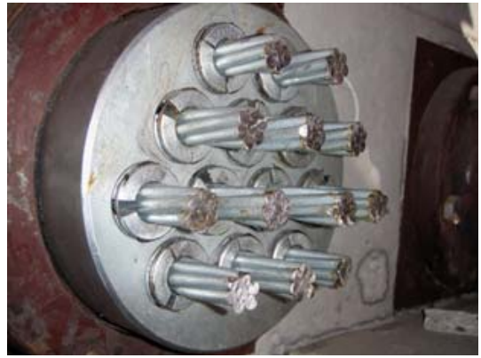
写真－6 PC鋼材および定着具の現況
