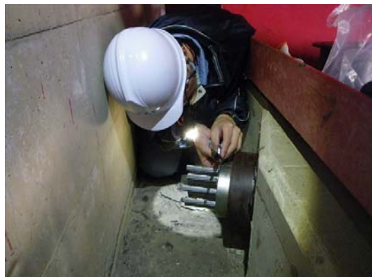
写真－8 ウェッジ出しろ測定状況
