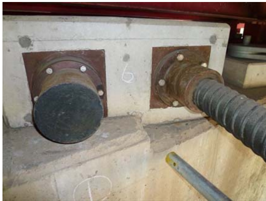
写真-2 定着部コンクリート
