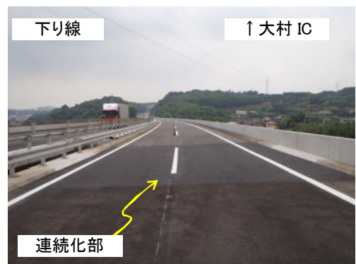
写真-4 橋面全景
