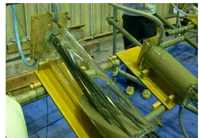
写真-7 グラウト充填状況
