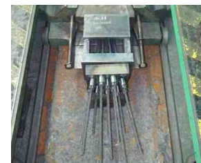
写真-4 緊張前 (支圧板との定着角7°)
