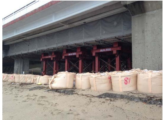
写真-3 待受けベント設置状況
