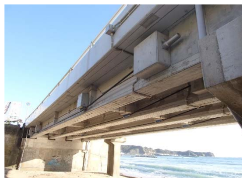
写真-5 外ケーブル補強状況
