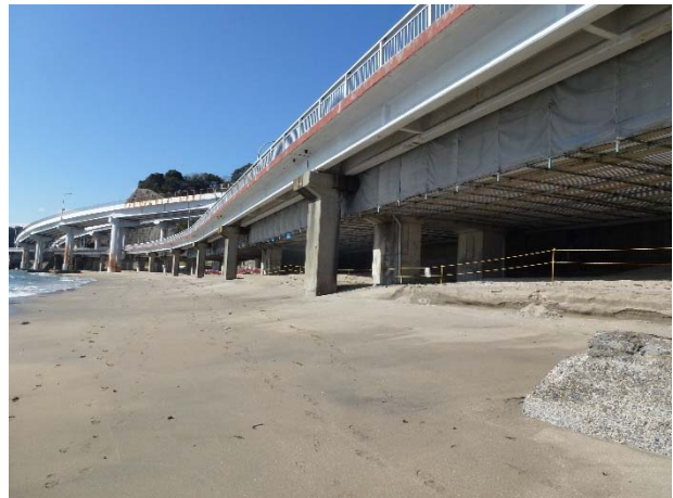
写真-1 勝浦大橋の全景
