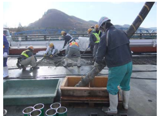
写真-3 現場打ち床版供試体の作製
