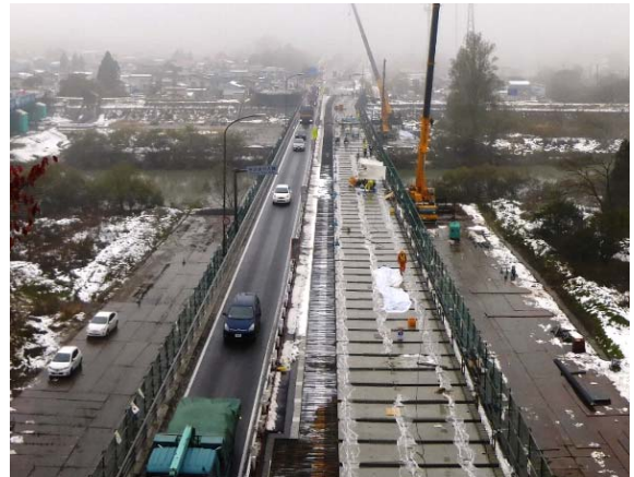
写真-1 工事状況
