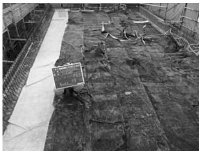
写真-10 保水養生マットの敷設
