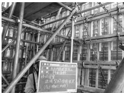
写真-1 透明型枠
