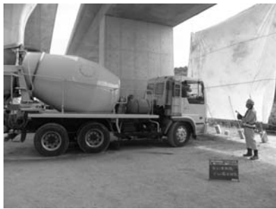
写真-4 生コン車への散水
