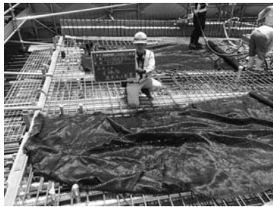
写真-5 遮光ネットの敷設
