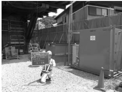
写真-7 機材配置状況
