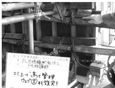
写真-2 充填確認状況
