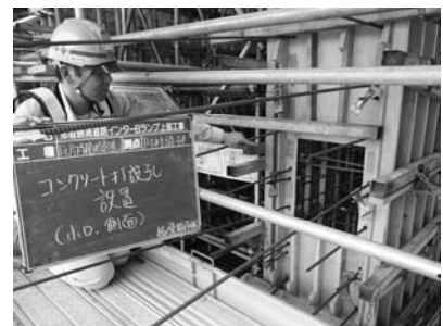
写真-3 生コン投入口
