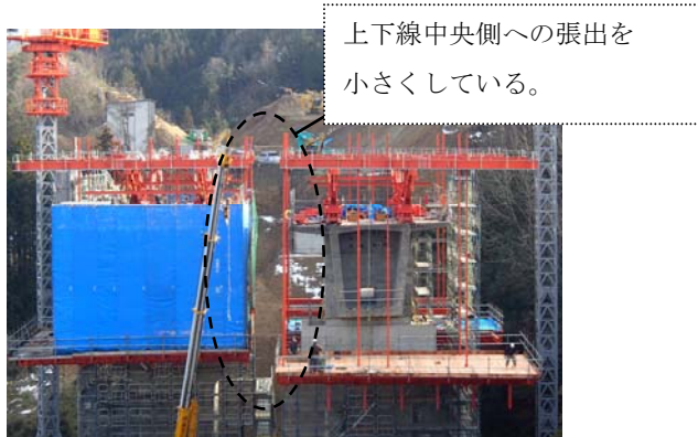
写真-1 架設作業車
