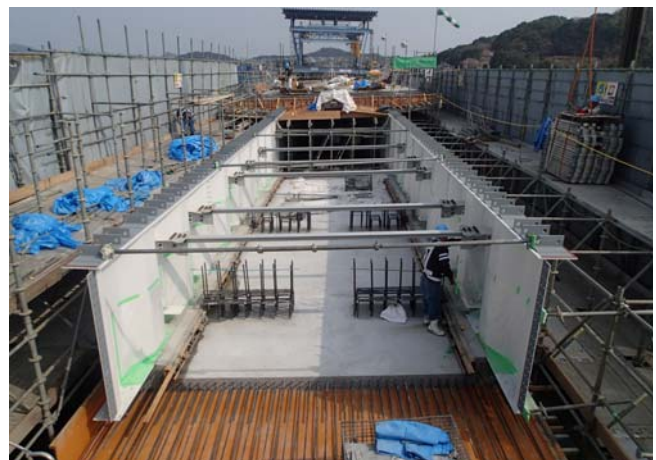
写真-1 固定支保工架設部施工状況
