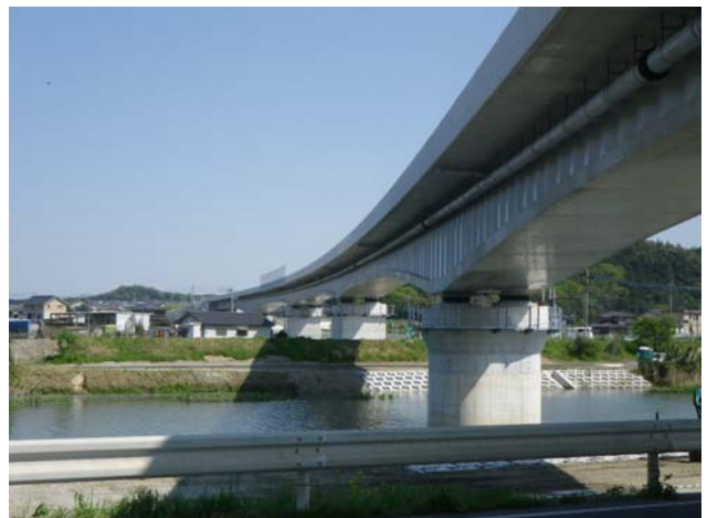
写真-3 完成写真
