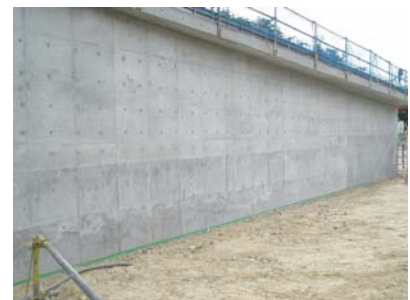
写真-1 A1橋台外観
