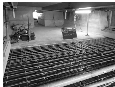
写真-4 FRP格子筋の配置状況
