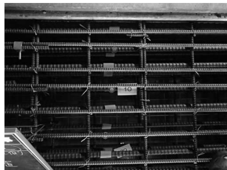
写真-3 補強鉄筋の配置状況
