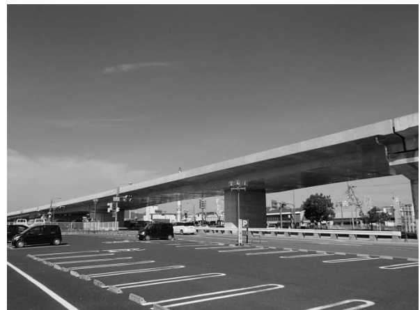
写真-5 完成写真
