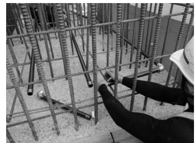
写真-1 配管状況
