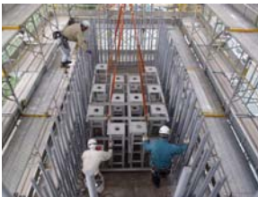
写真-1 鉛直PC鋼材架台
