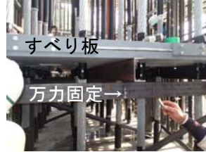
写真-5 すべり板挿入 写真-6 鋼材盛り替え 写真-7 すべり板固定
