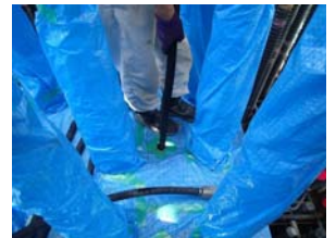
写真-8 第2ロットコンクリート打設
