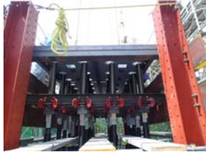
写真-5 すべり板挿入 写真-6 鋼材盛り替え 写真-7 すべり板固定
