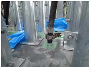
写真-9 無収縮モルタル打設状況
