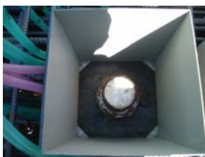
写真-19 箱抜き型枠設置
