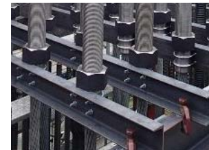
写真-3 鉛直PC鋼材架設状況
