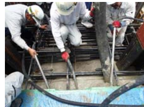
写真-8 第2ロットコンクリート打設
