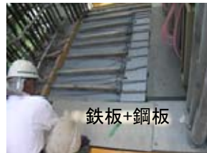
写真-11 鉄板敷設状況
