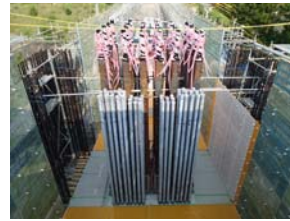
写真-13 鉄筋キャップ挿入 写真-14 上部キャップ 写真-15 取付完了
