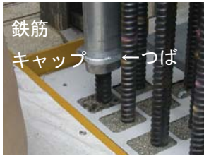
写真-13 鉄筋キャップ挿入 写真-14 上部キャップ 写真-15 取付完了
