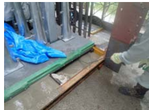
写真-9 無収縮モルタル打設状況
