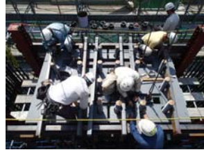
写真-5 すべり板挿入 写真-6 鋼材盛り替え 写真-7 すべり板固定
