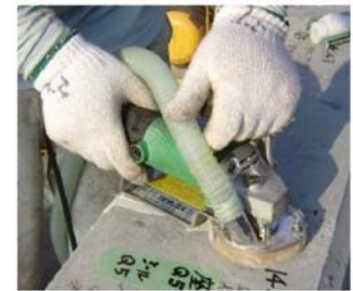
写真-3 ケレン撤去状況
