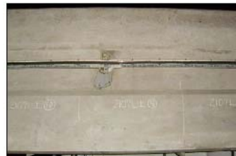
写真-6 ひび割れ注入工完了
