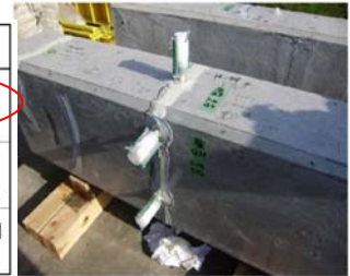
写真-2 注入試験状況
