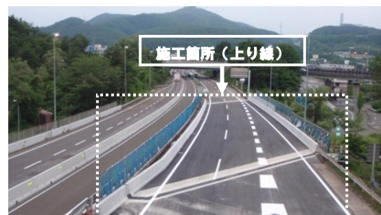
写真-4 上り線工事完了
