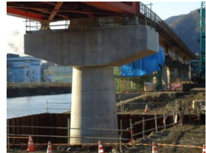
写真-3 躯体の再構築
