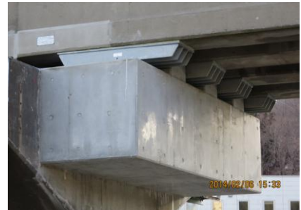
写真-6 桁座の拡幅
