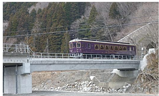
写真-8 完成後のPCホロースラブ桁
