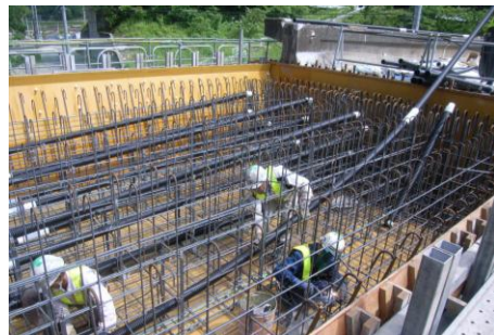
写真-7 施工状況(シースの設置)
