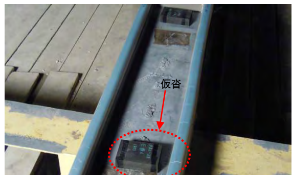
写真－3 仮沓による高さ調整
