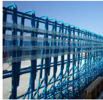
写真-5 耐アルカリ性 ガラス繊維材の設置状況
