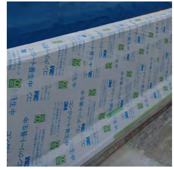
写真-6 保水養生状況
