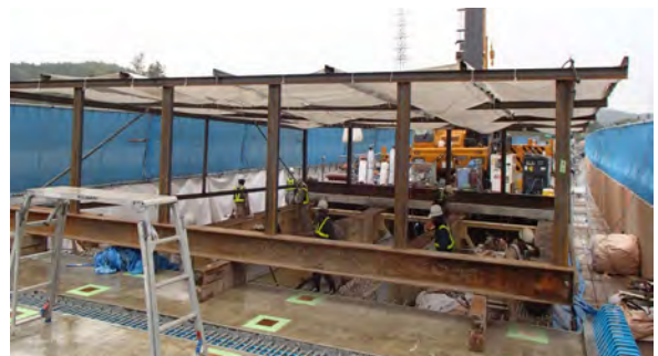
写真－4 全天候型養生状況
