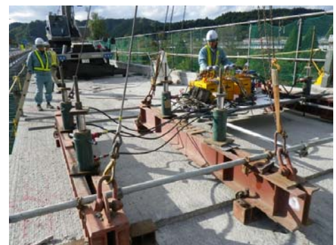
写真-1 既設床版撤去状況
