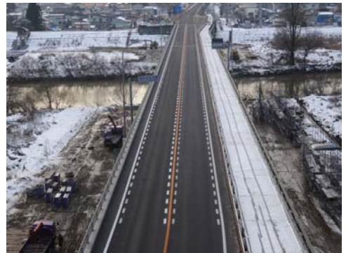
写真-5 2車線解放状況
