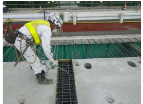
写真-3 けい酸塩系表面含浸材の噴霧状況
